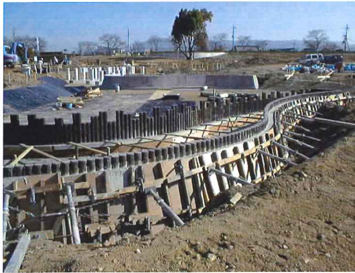
景観池築造工事①
