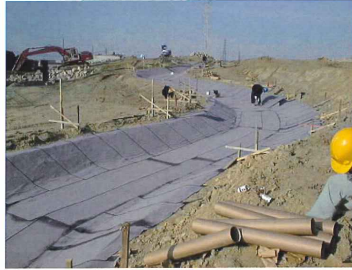
景観池築造工事②
